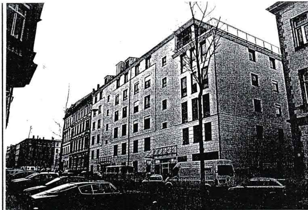
Objektansicht vom 20. Dezember 2002
